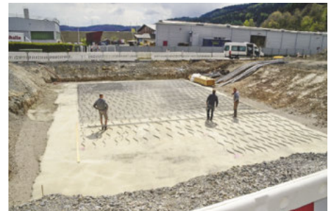
/ Das neue Bürogebäude wird eine Grundfläche von 50 x 20 m haben und soll im Frühjahr 2018 fertig sein.
